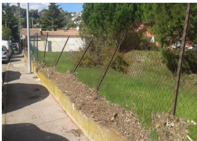
FIGURE 24 : PLOIEMENT DE CLOTURES SOUS L'EFFET DE L'EAU – CRUE DU 03/10/2015
