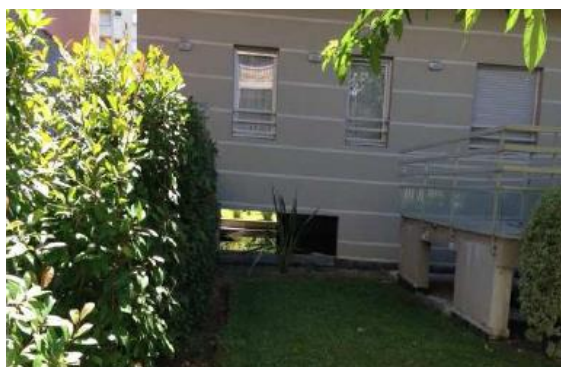
FIGURE 26 : EXEMPLE D'HABITATION FREQUEMMENT INONDEE SITUEE AU NIVEAU DU THALWEG ORIGINAL
