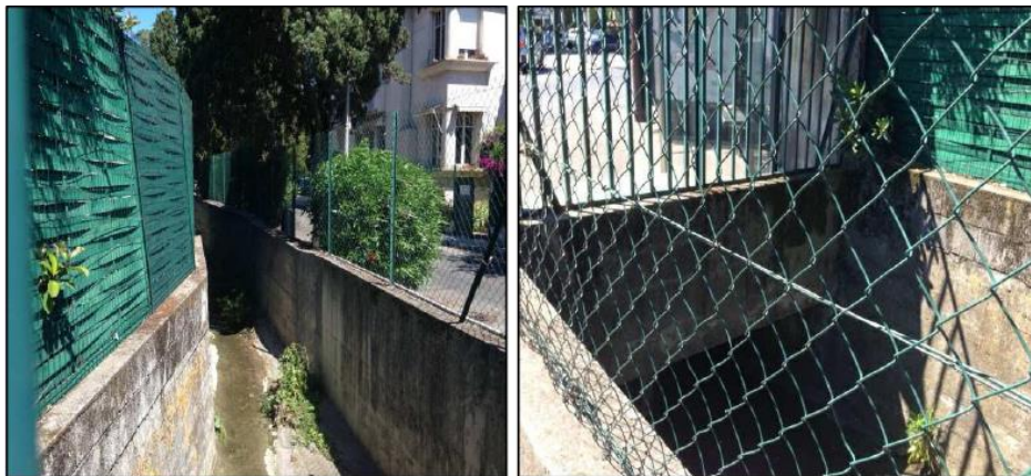
FIGURE 25 : VALLON DES FRERES GARBERO EN AVAL DE L'HOPITAL – ENTREE PASSAGE COUVERT
