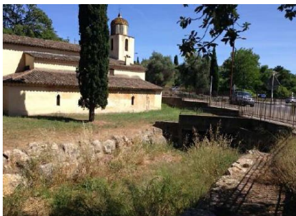
FIGURE 29 : ENTREE PASSAGE COUVERT CHAPELLE ST JEAN
