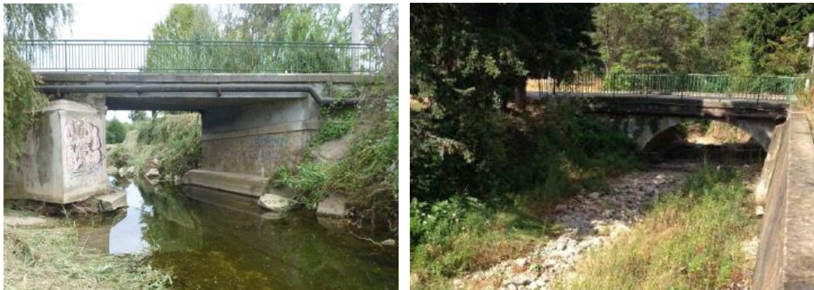
FIGURE 21 : PONT BREJNEV A GAUCHE ET PONT DU GOLF SUR LA VALMASQUE A DROITE
