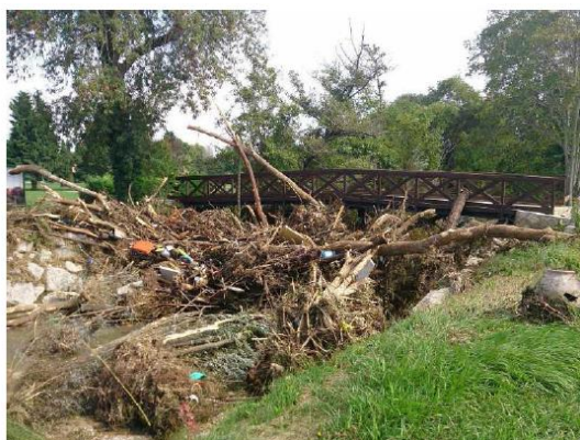
Passerelle du Golf
