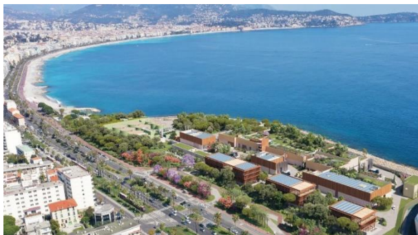
Figure n°12. VUE DU BATIMENT TERTIAIRE QUI ACCUEILLERA LES SERVICES TECHNIQUES DE EAU D'AZUR ET L'ODD (HORS PROJET)
