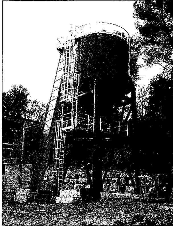
Figure 8 : Silo de stockage des boues sèches
