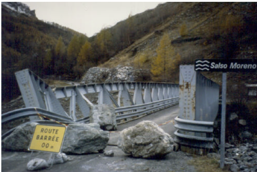
Photo 3 : Pont sur le Salso Moreno endommagé par des chutes de blocs rocheux lors des intempéries des 5 et 6 novembre 1997 (cliché Service R.T.M.-06, novembre 1997).
