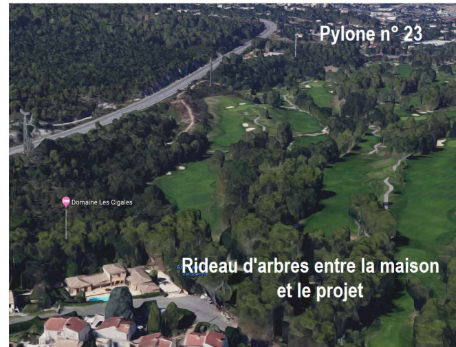
Vue aérienne Nord proche avec le même axe
