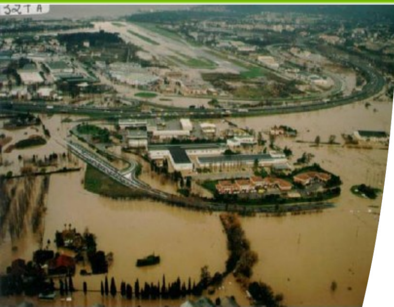
Inondation de 1996 – échangeur 41
