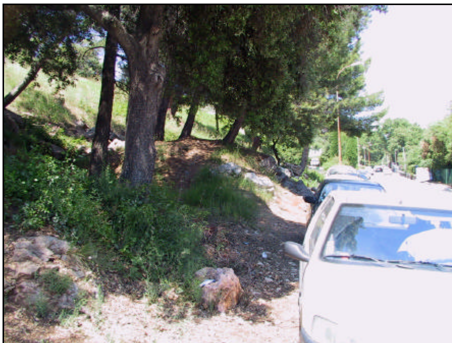
Photographie 11. Blocs éboulés à proximité de la carrière.
