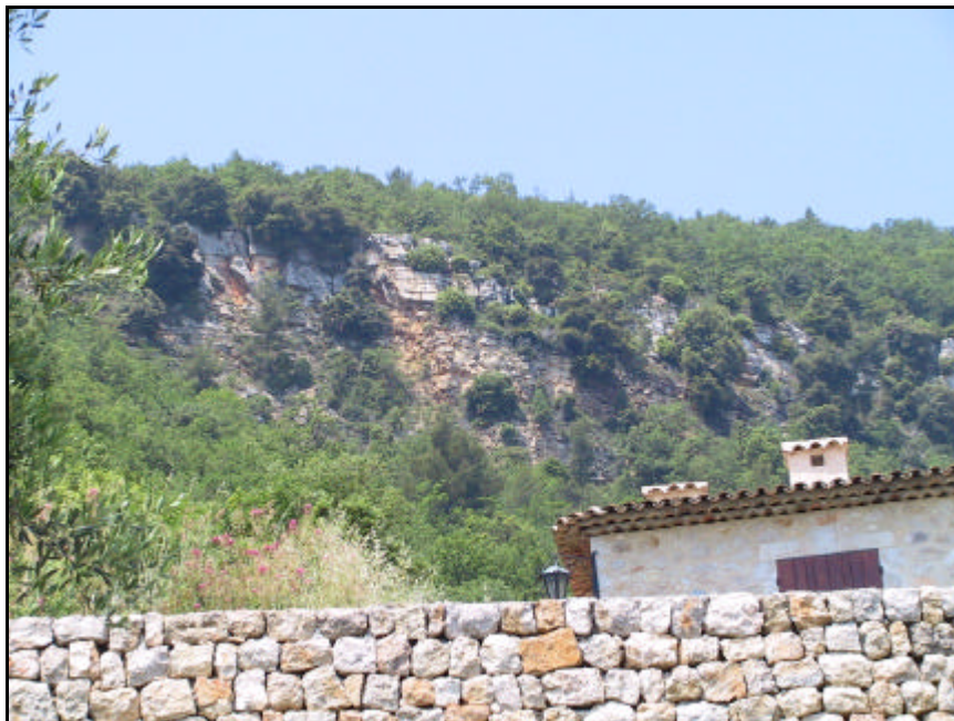
Photographie 15. Illustration du risque de chutes de rochers.
