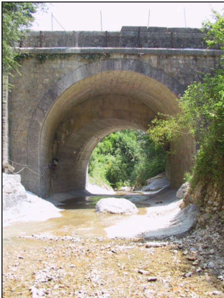
Photographie 4. Pont de la D4 au-dessus du Vallon des Ribes.
