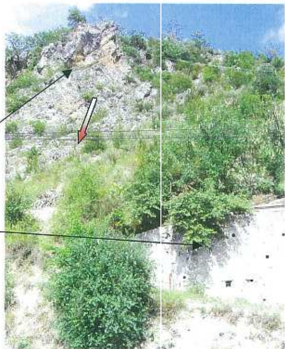
Photographie 16 : Eperon rocheux situé à proximité du hameau de Villetalle
