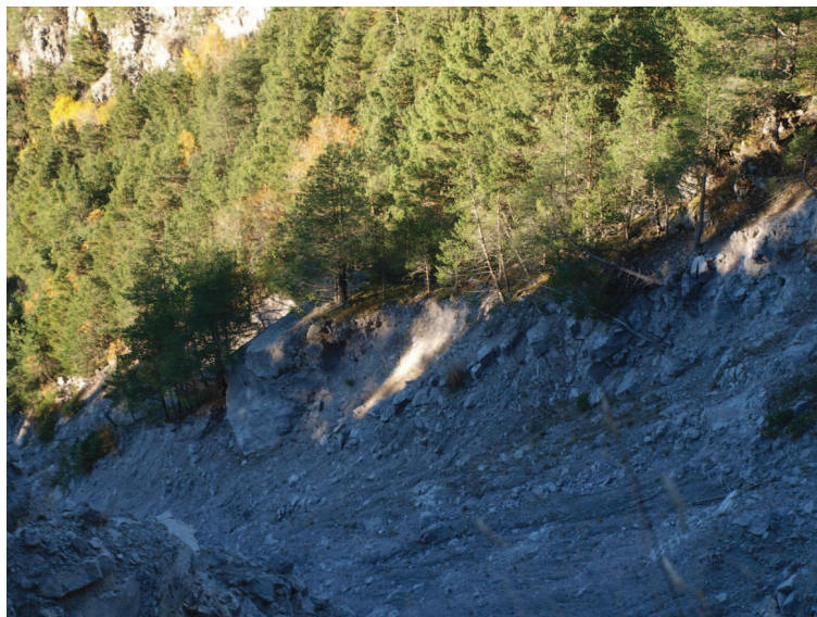
Photo 4 : Phénomènes de ravinement fort et chute de blocs au niveau du Vallon d'Albérans
