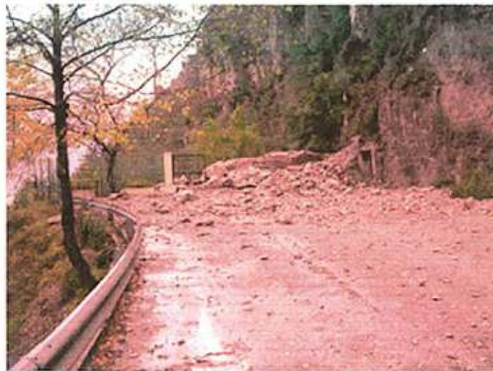
Eboulement sur le parking Nord du village en décembre 2002
