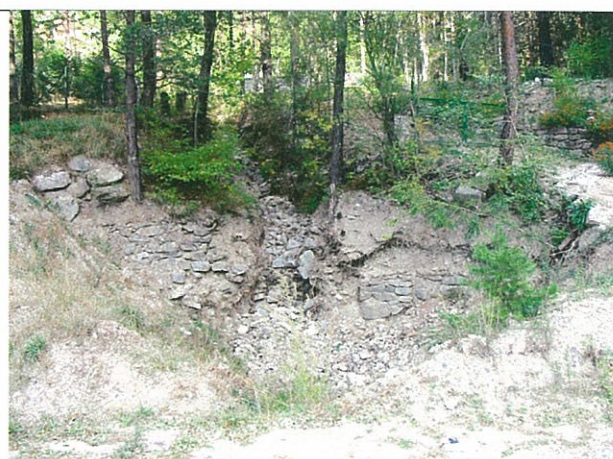
Photo 6 : limite torrent / RD 2205
