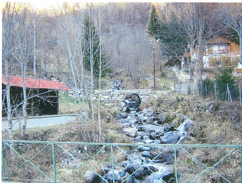
Photo 2 Torrent des Ténibres, amont de la RD 2205.
