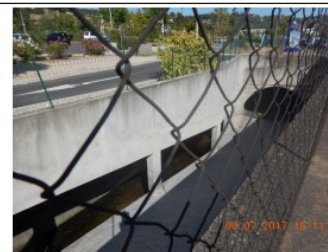
Illustration 3 Ouvrage galerie sur le Riou Blanquet
