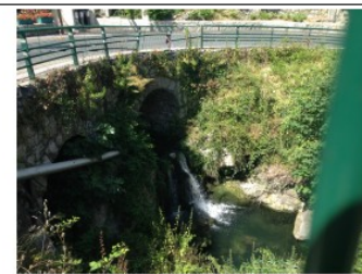
Illustration 2 Pont suivi d'un seuil sur le Riou Blanquet
