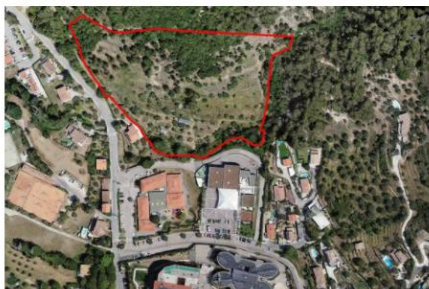
Vue aérienne rapprochée du site de projet. Périmètre de la Déclaration de Projet.
