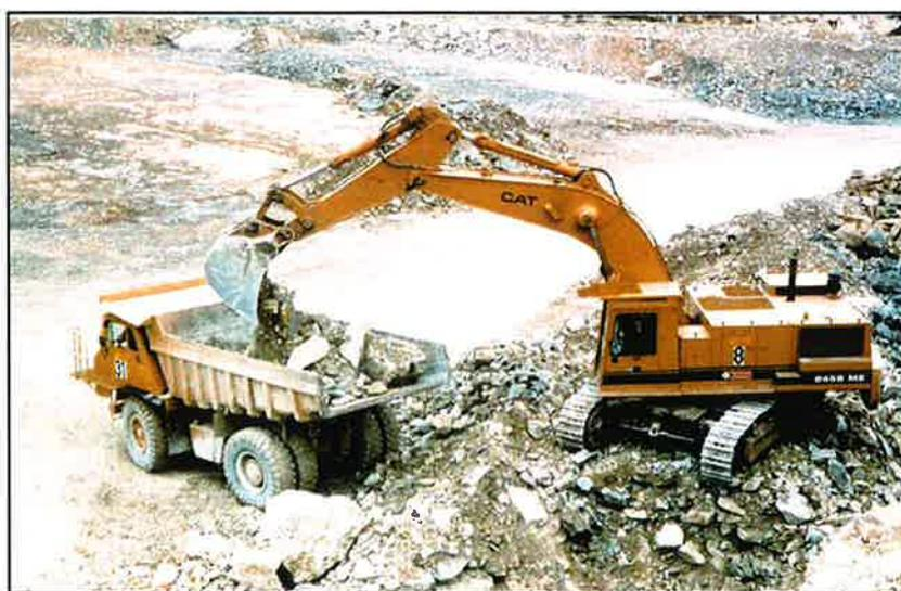
*Récupération des matériaux à la pelle hydraulique et transfert par dumper*
