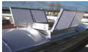
Rehausse dans voûte
