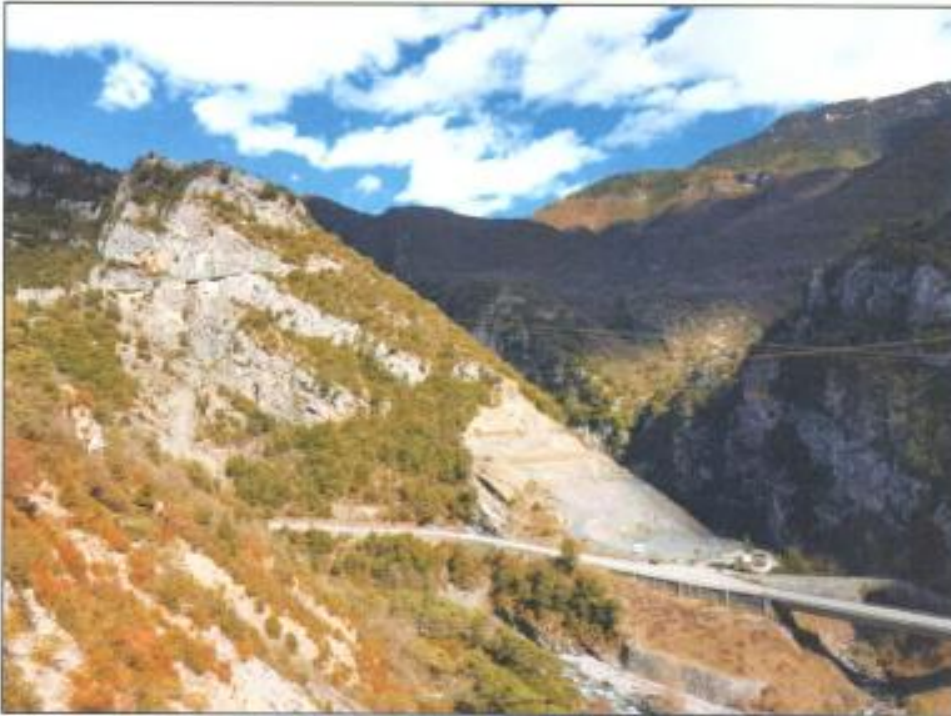
Photographie de l'état actuel de la carrière et du versant en amont - Source : Geo-GC
