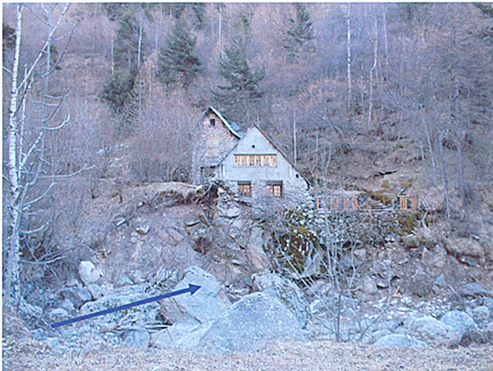
Photographie 8 - Erosion de berge résultant de l'action de la Gordolasque, la flèche indique le sens de l'écoulement.
