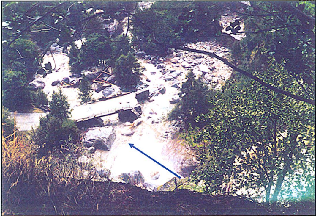
Photographie 1 - Pont de la cascade détruit par la crue de la Gordolasque de 1993.
