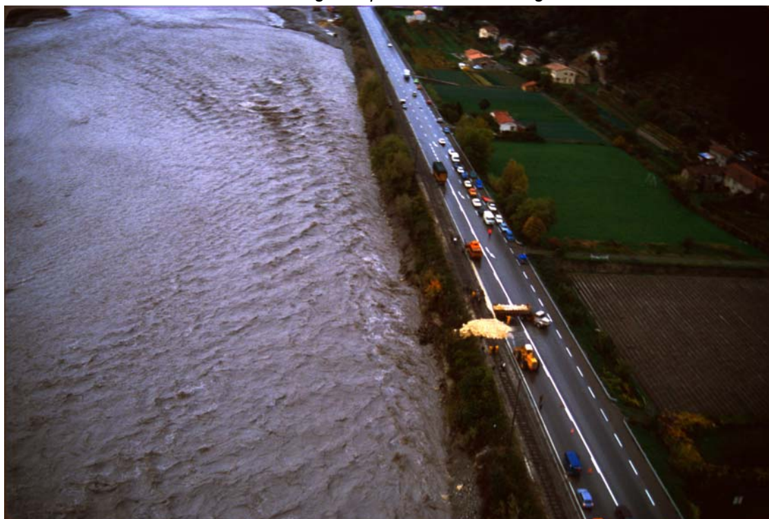
Intervention en urgence pour consolider la digue
