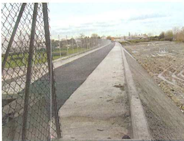
La digue des Français au niveau du MIN en aval immédiat de l'ouvrage autoroutier
