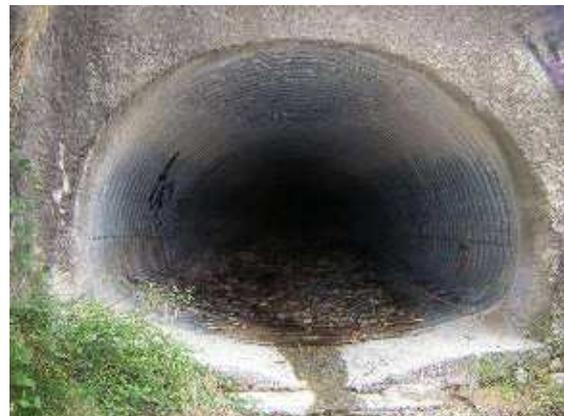
Entrée et sortie de la buse ARMCO
