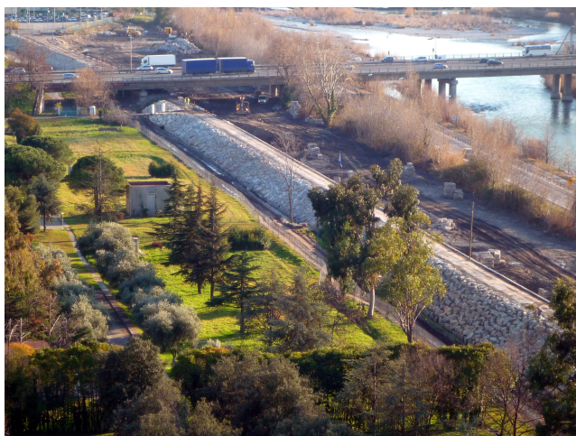
Travaux de consolidation de la digue des Français – hiver 2010 (photo : DDTM 06)
