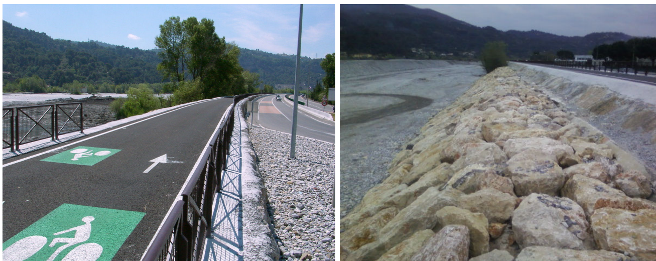
Rehausse et consolidation de la digue de Carros – Le Broc (photos : DDTM 06 – juin 2010)
