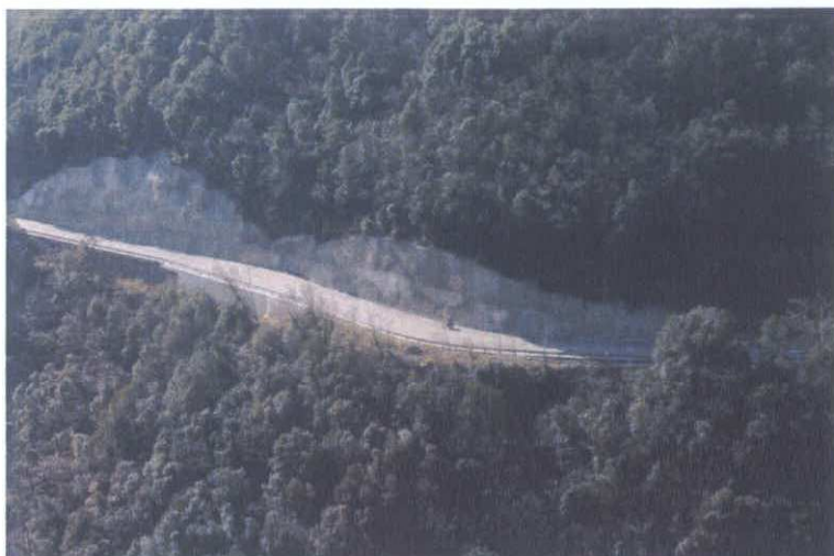
Paroi béton projeté sur le CD2566 – photo Géolithe 02/06
