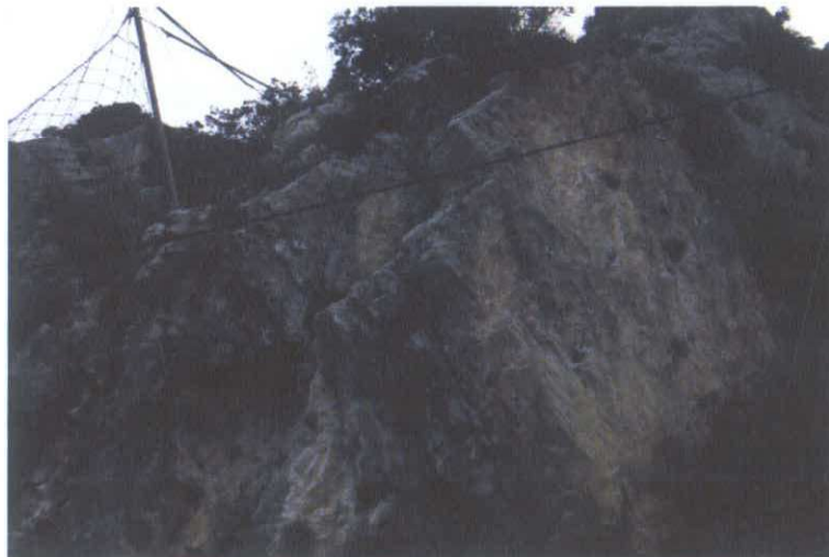
Ancrages au Ciamaïro – photo Géolithe 02/06
