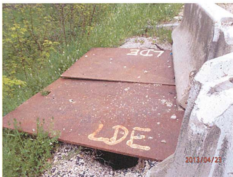
Photo n° 21 - Ouverture d'une cheminée verticale Chemin des Basses Treilles
