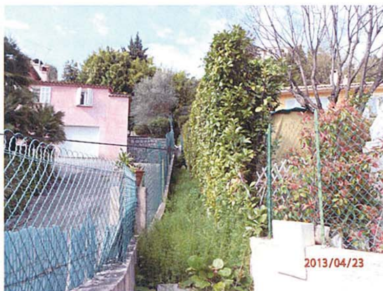
Photo n° 18 : Amont du chemin de la Treille Venues d'eau parasites
