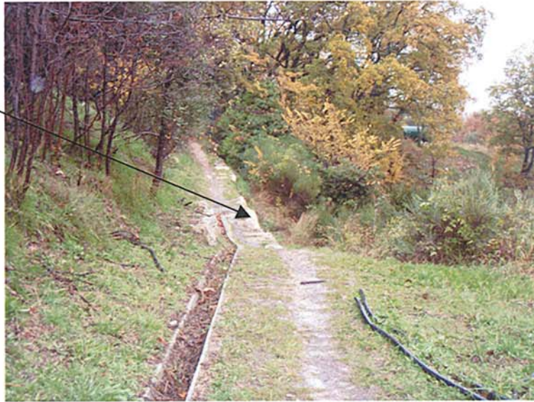
Photo n° 7 : Vue de la partie sommitale des enrochements cloutés
