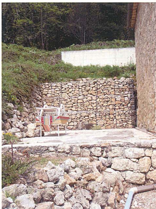
Photo n° 9 : Vue des ouvrages de protections mis en place suite aux mouvements de terrain en amont de la RD3
