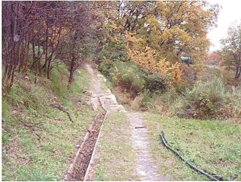
Photo n° 14 : vue du chemin de Saint Andrieu Les enrochements cloués sont visibles au niveau du chemin
