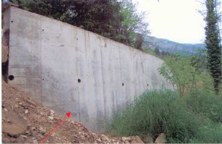
Mur en béton armé mis en oeuvre sur le talus aval du chemin de Calempol.
