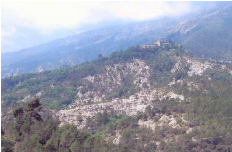
Versant en aval du village sujet à des ravinements importants de ses matériaux marneux avec un caractère évolutif non négligeable.
