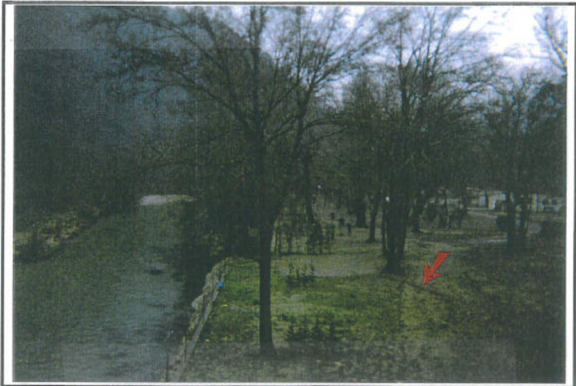
1-Aval du profil P8; laisse dans le camping rive droite (cote de 38.70mNGF environ)
