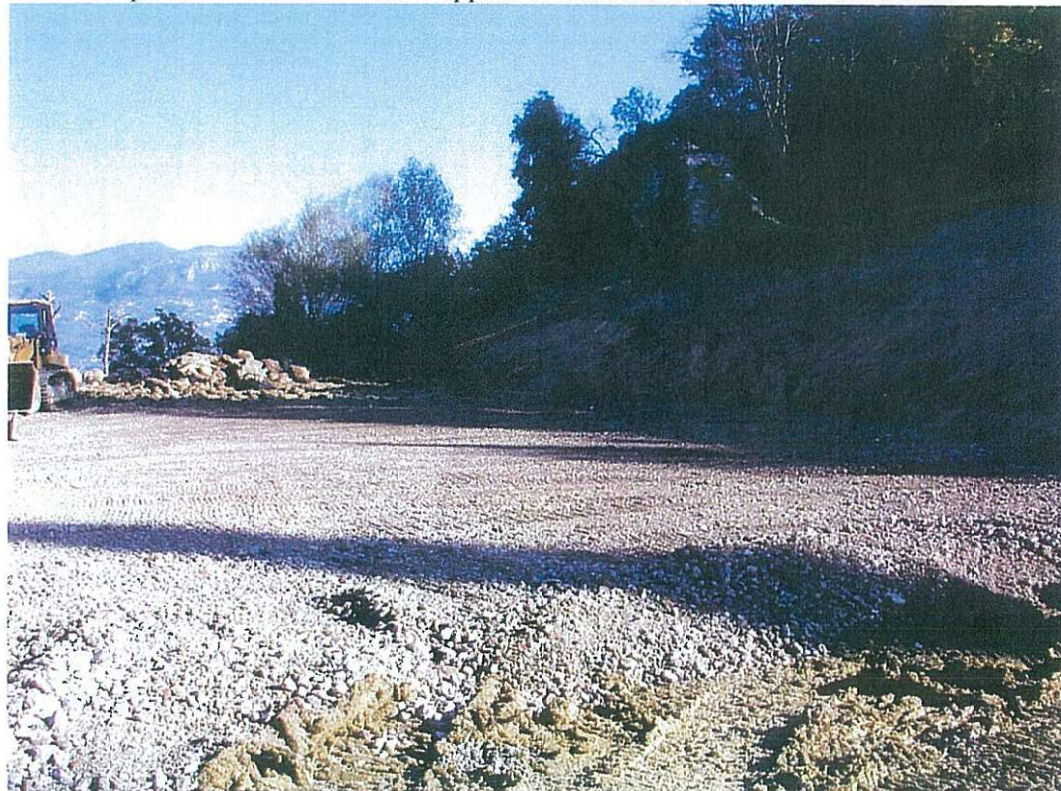
Vue de la plateforme terrassée avec apport de matériaux drainants de couverture
