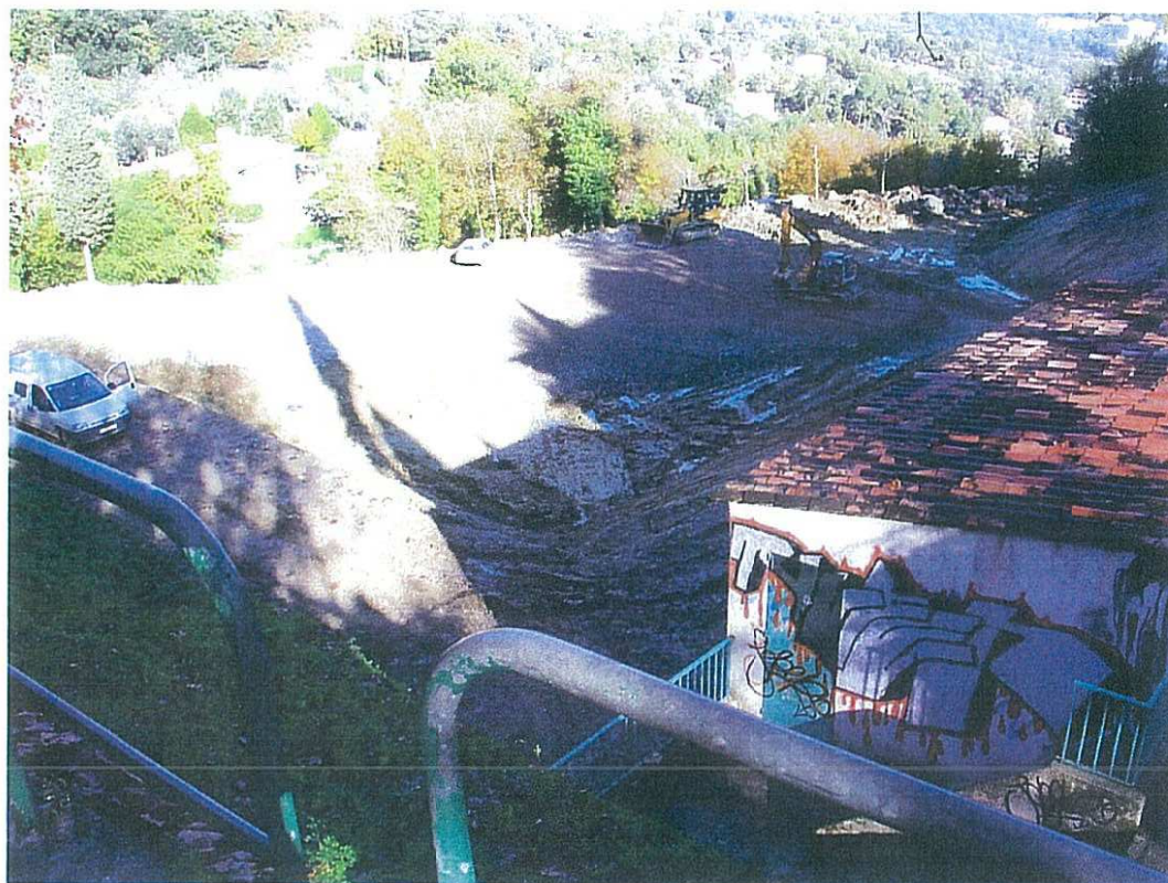
Vue de la plateforme terrassée avec apport de matériaux drainants de couverture
