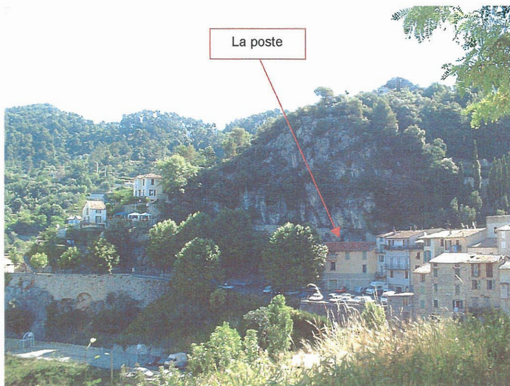
Vue de la barre rocheuse située au dessus de la poste
