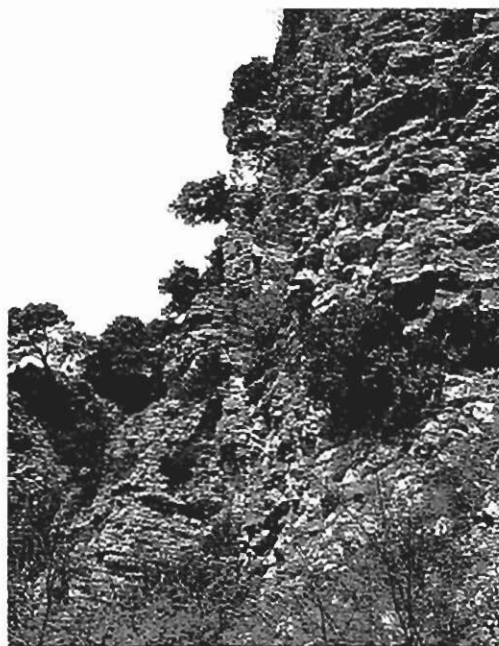
Exemple de calcaires et dolomies du Jurassique fracturés, érodés et parfois parcourus de failles rencontrés au sommet de « Sur la Colle »
