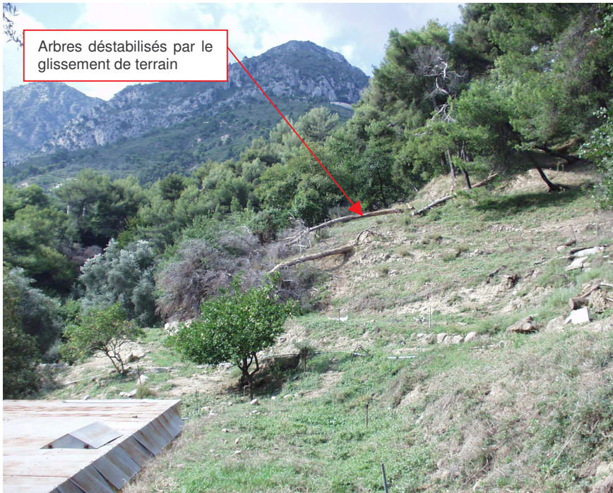
Glissement de terrain au quartier du Pian
