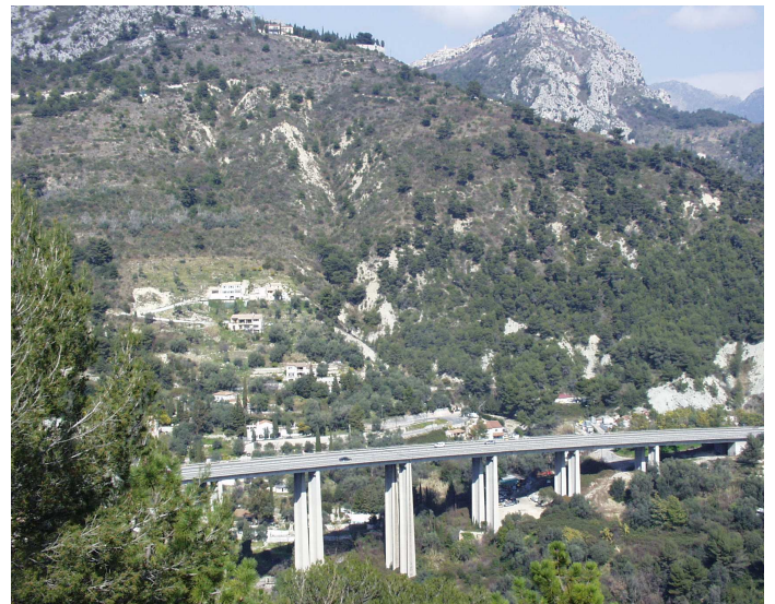
Vue générale du quartier de la Vignasse
