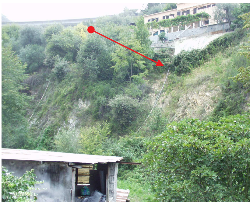
Glissement de terrain sous une habitation du quartier St Sauveur
