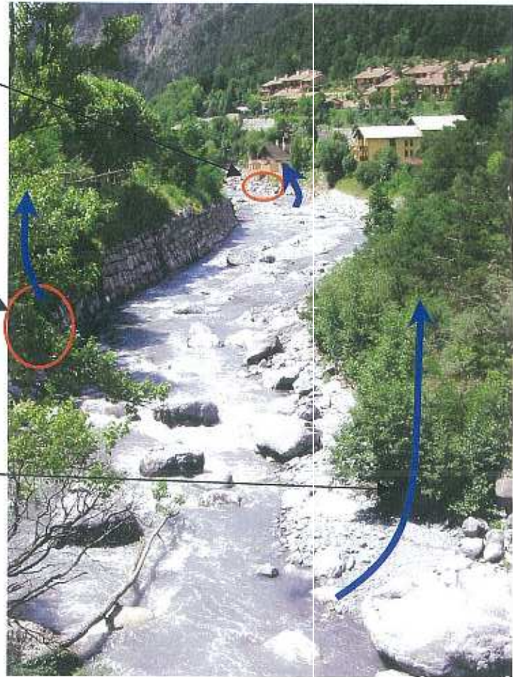
Photographie 17: Les différents points sensibles à l'aval du pont de Sauze
