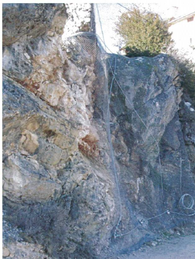
Photo 4 : Mise en place d'une couverture grillagée (photos Géoingénierie)
