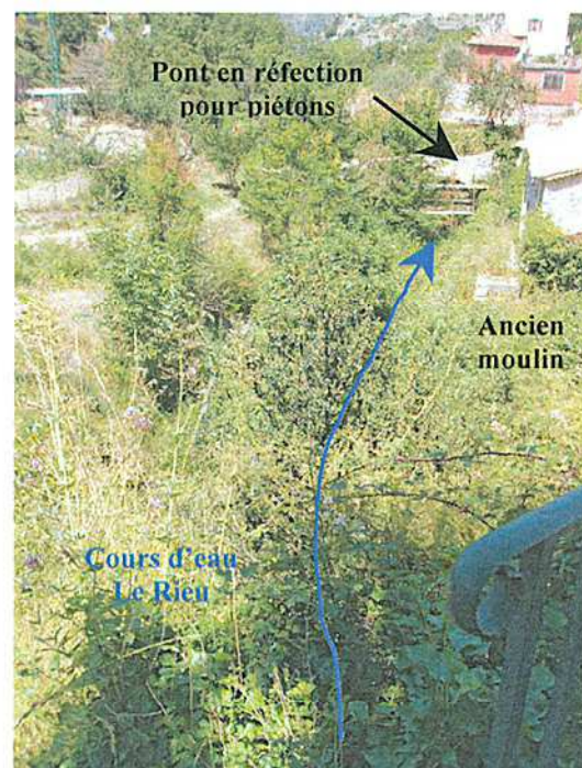
Photo n°10 : Le Rieu à l'aval du pont de la RD19.
