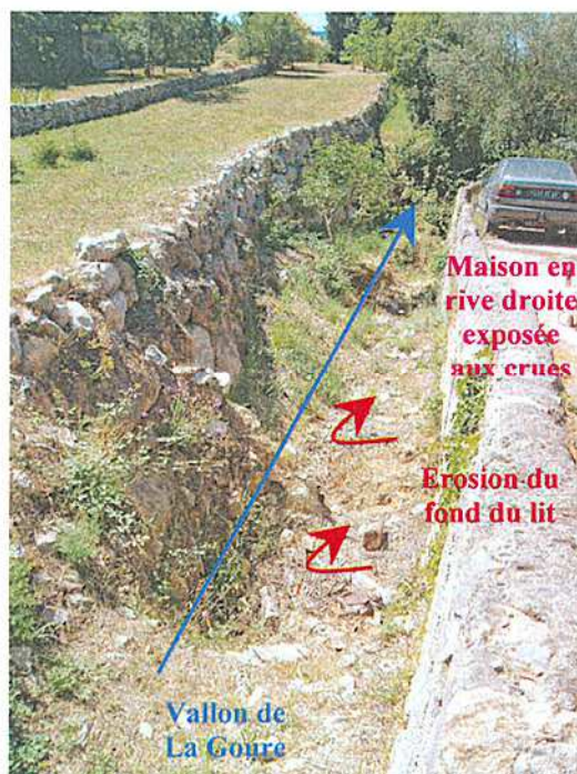
Photo n°11 : Lit mineur de la Goure vue vers l'aval
