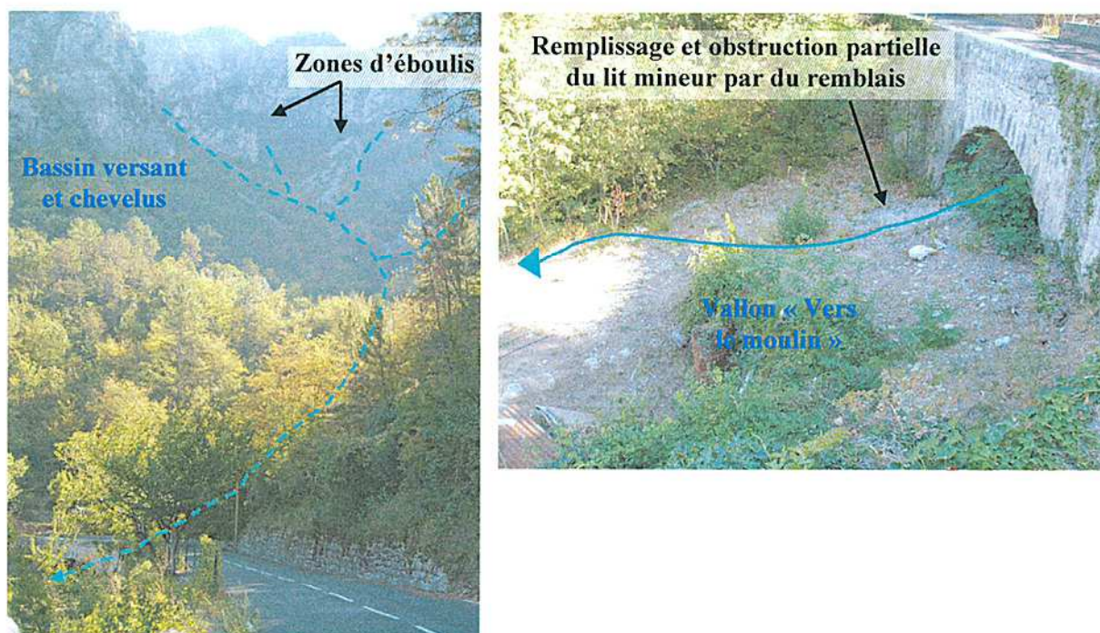
Photo n°7 et 8 : Bassin versant « Vers le moulin », situation à l'aval du pont de la route RD19.
