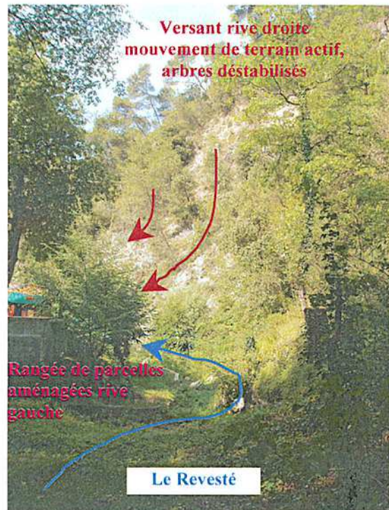
Photo n°20 : Zone urbanisée rive gauche/ Glissements actifs rive droite
