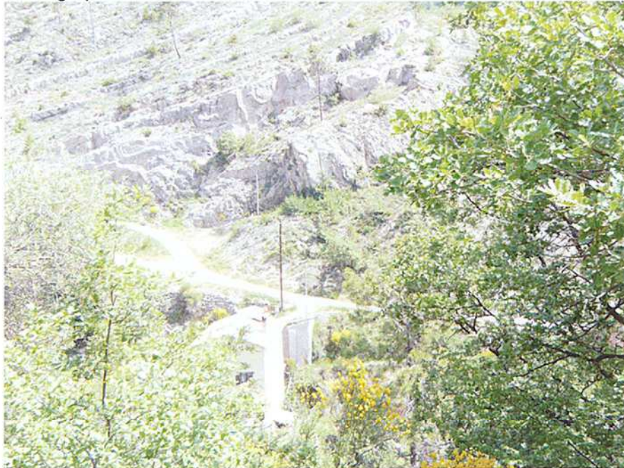
Photographie 1 : Chutes de blocs au niveau du chemin de la Foux (cliché RTM 06)
