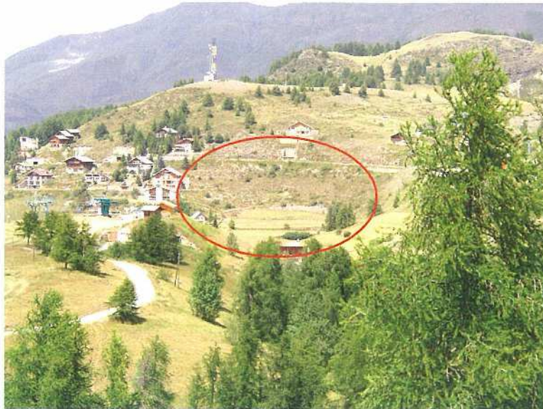
Photographie 20- Zone d'effondrement derrière le centre administratif avec présence de chute de pierre d'intensité faible
