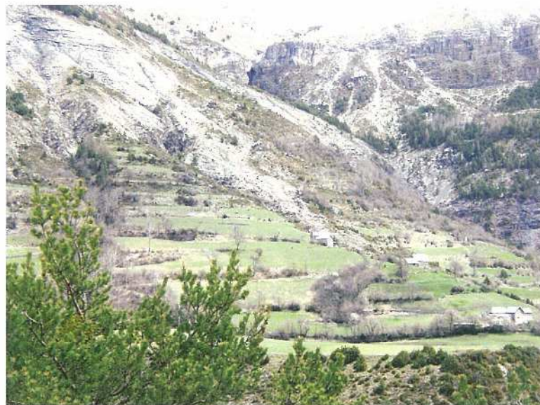
Photographie 11- Ravinement dans le secteur des Mians
