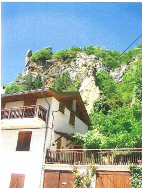
Photographie 14- Escarpement surplombant les habitations dans le secteur de la Para
