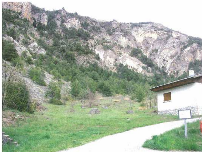
Photographie 16- Présence de blocs aux abords des chalets
