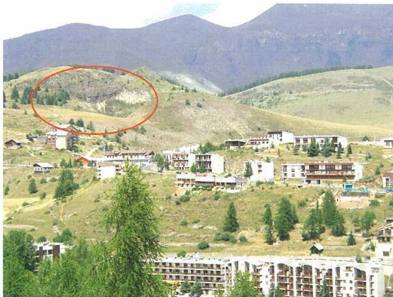
Photographie 19 - Effondrement au Chastellan (21/07/2004)
