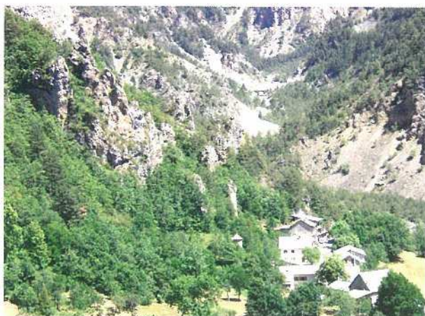
Photographie 13- Secteur de la Para soumis à un aléa élevé de chute de pierres et de blocs
