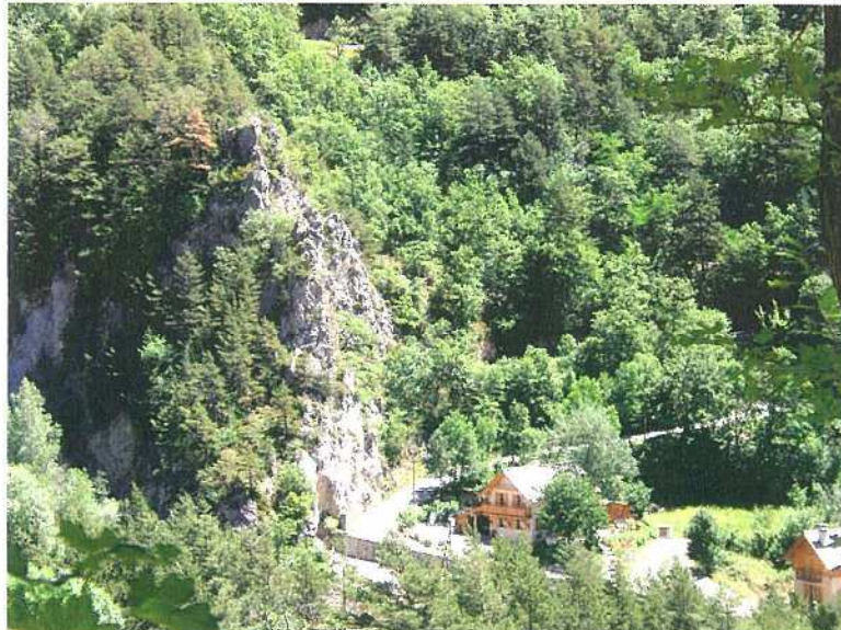
Photographie 17- Habitation soumise à un aléa moyen de chute de matériaux rocheux
