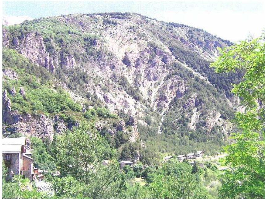
Photographie 6- Chute de blocs et de pierres
