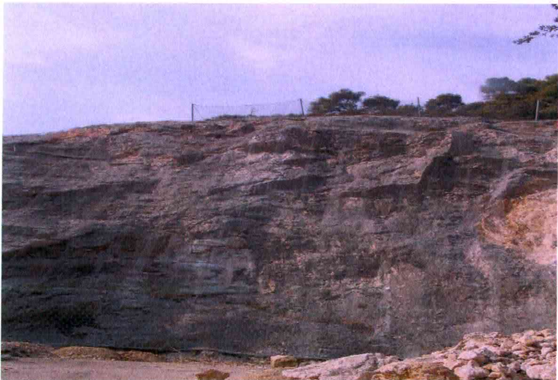
Les allées Victoria -Protections 3
