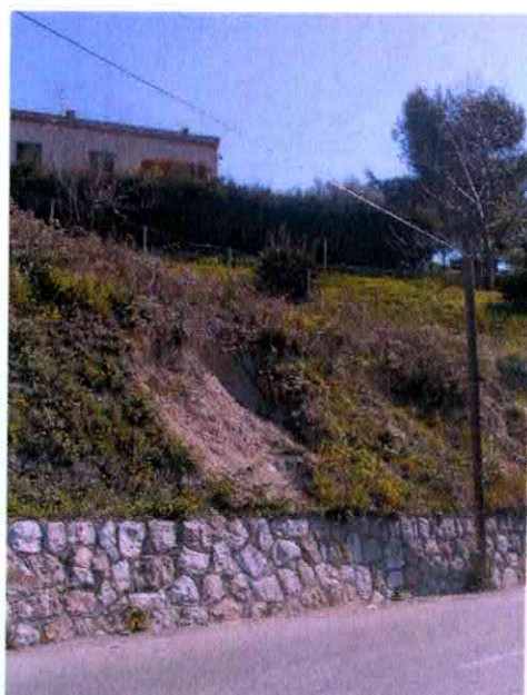
Petite loupe d'arrachement dans le talus de la route de l'Abadie
