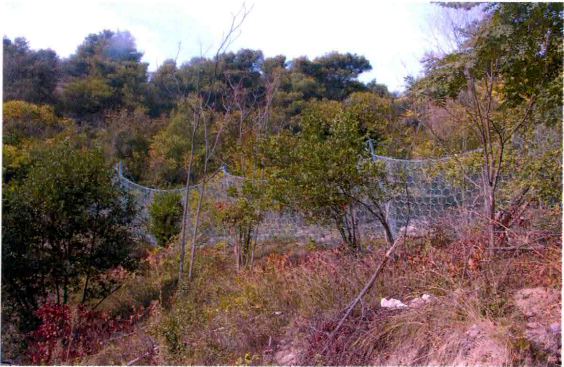
Les allées Victoria -Protections 2
