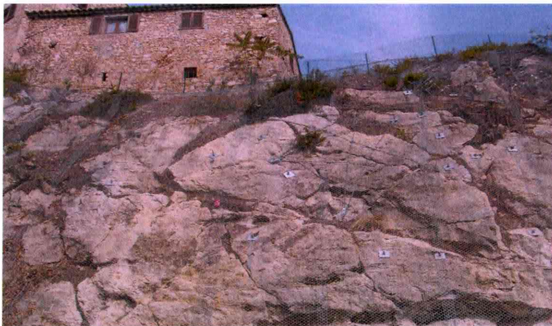
Les allées Victoria -Protections 1
