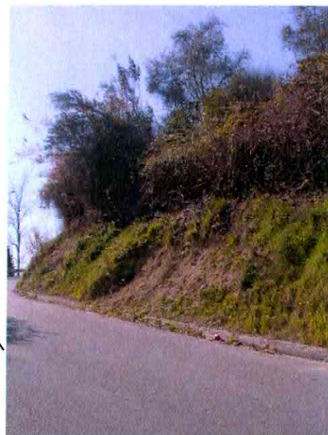
Petite loupe d'arrachement dans le talus de la route de l'Abadie
