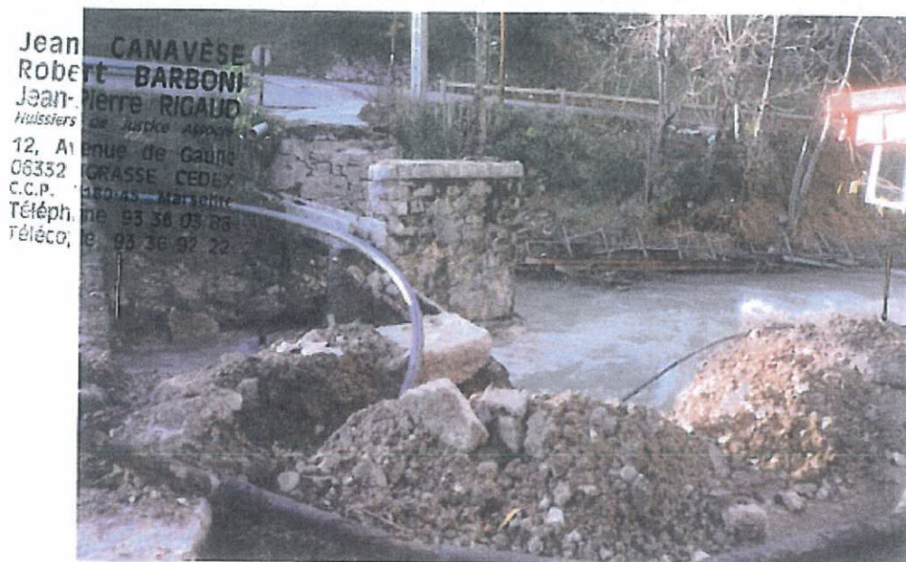
Illustration 8 : crue de l'Estéron du 05/11/1994 emportant le pont communal (source : Procès-verbal de constat établi le 08/11/1994).
