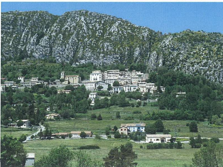
Illustration 5 : chute de blocs rocheux en amont du village (cliché RTM 06 - juin 2013).
