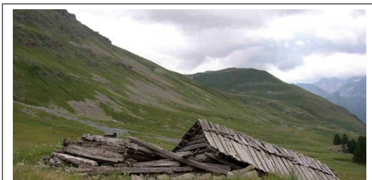
Photo n°12 : Chalet détruit par une avalanche au Clos de Bousiéyas.
