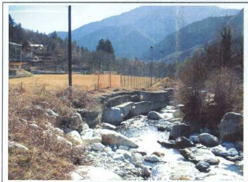
Photo 9 : protection de berge en rive gauche au niveau du stade.
