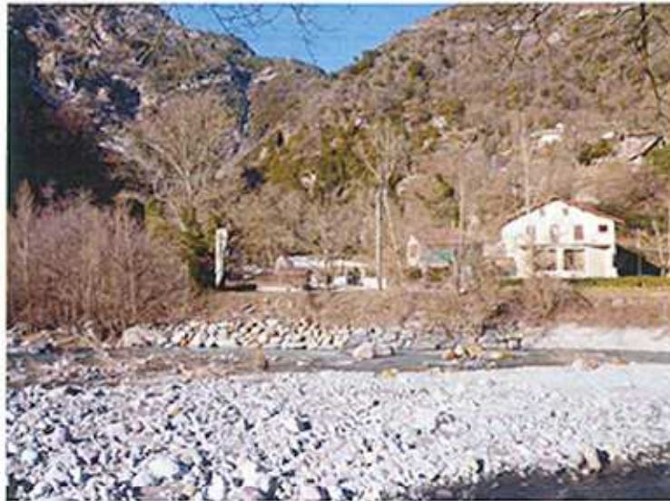
Photo 6 : vue de la rive gauche de la Vionène
