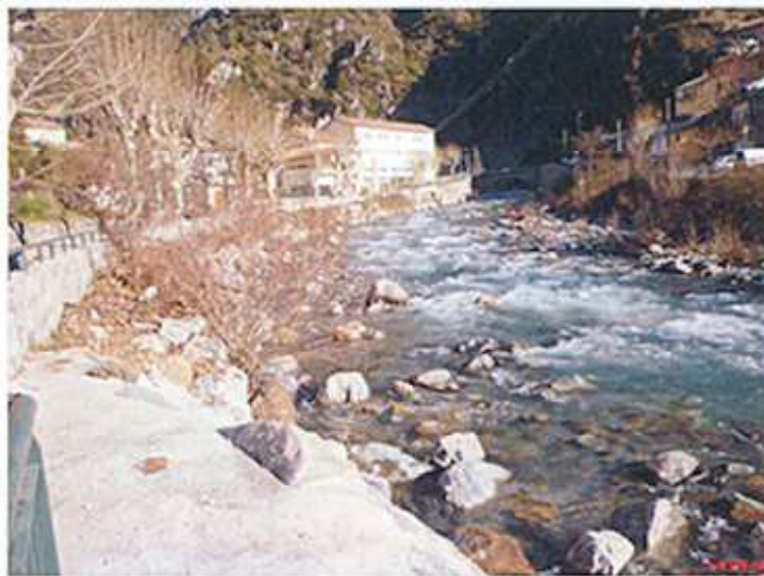
Photo 3 : vue de la Tinée à l'aval du pont voûte
