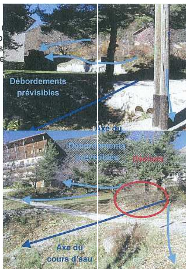
Photographie 8 : Vue du troisième passage à gué, équipé de deux buses (Diamètre 400mm)
