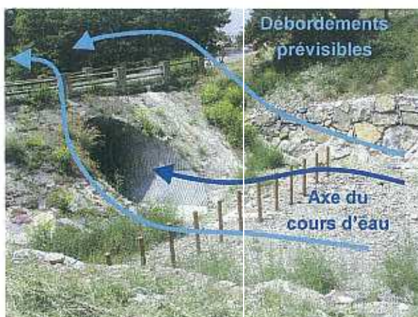
Photographie 5 : Vue vers l'aval de la buse et du seuil filtrant.
