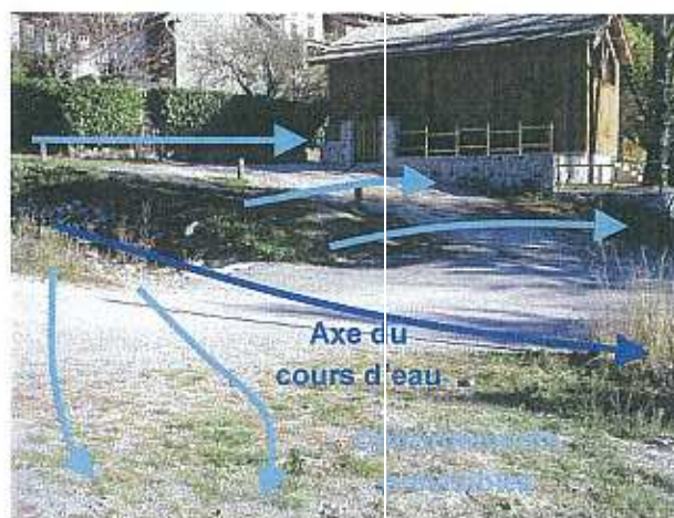
Photographie 13 : Passage goudronné et busé (2 X Diamètre 30 cm) dans le lit mineur
