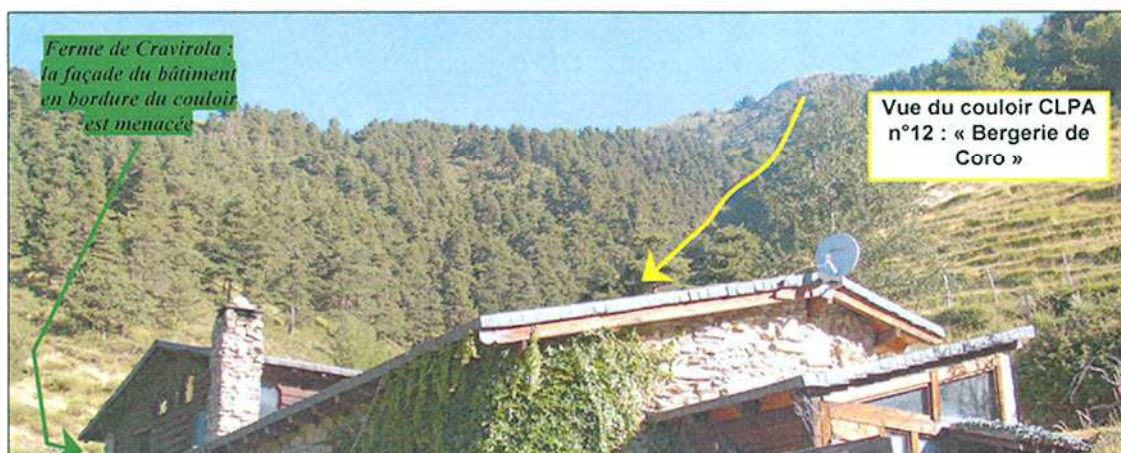
Illustration 34 : Vue du couloir d'avalanches du vallon de Coro / ferme de Cravirola
