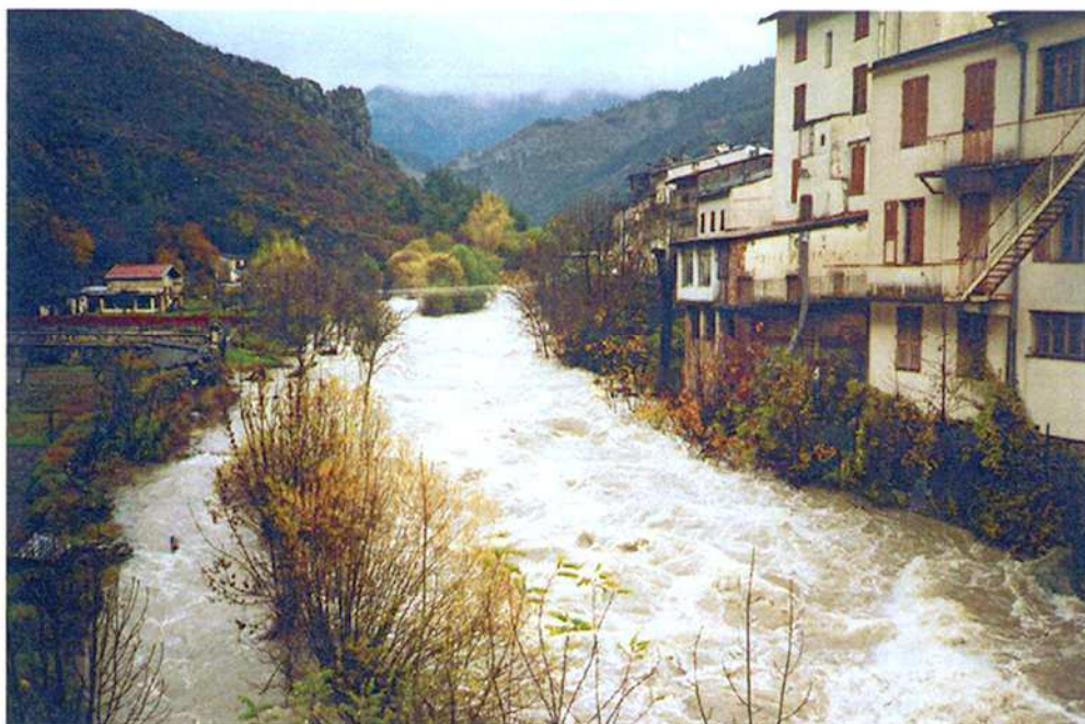
Photos RTM Levenza crue du 16/11/2002
