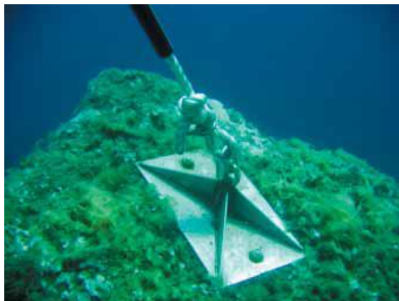
Figure 23 : Scellement dans la roche
