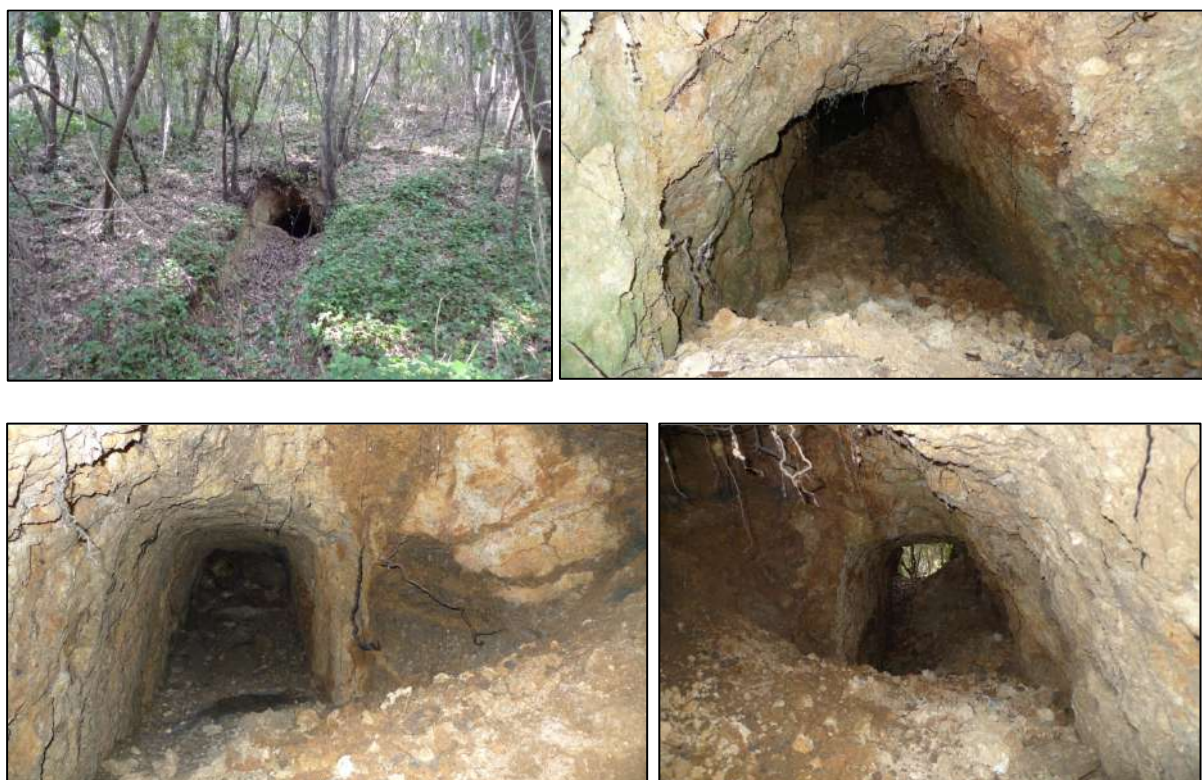
VALMASQUE - Galerie pénétrable G1 dans des terrains sablo-gréseux bouillants
