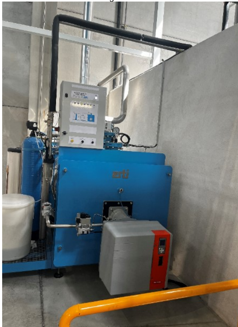
Vue côté droit du local
